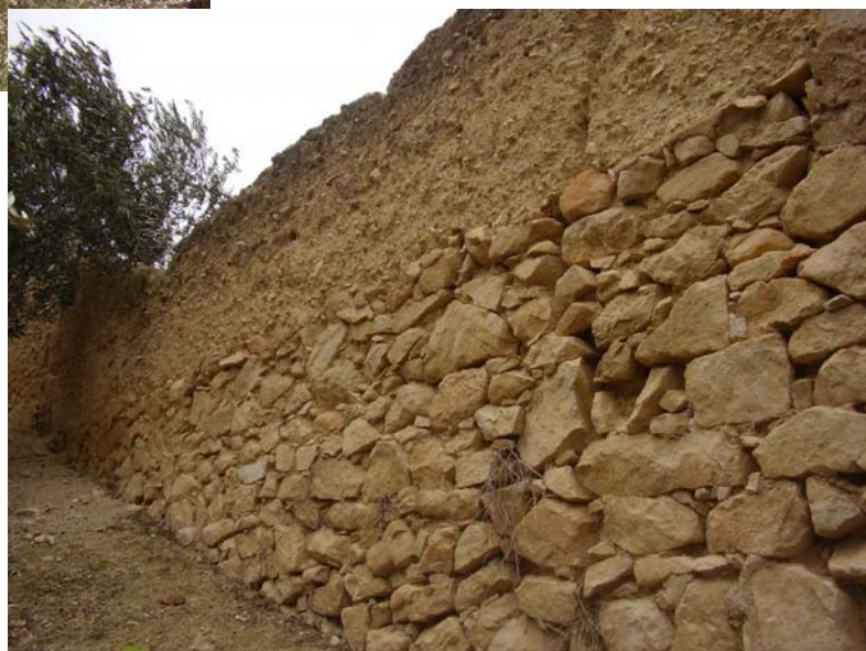
Foto 2. Vista de la pared Norte.
